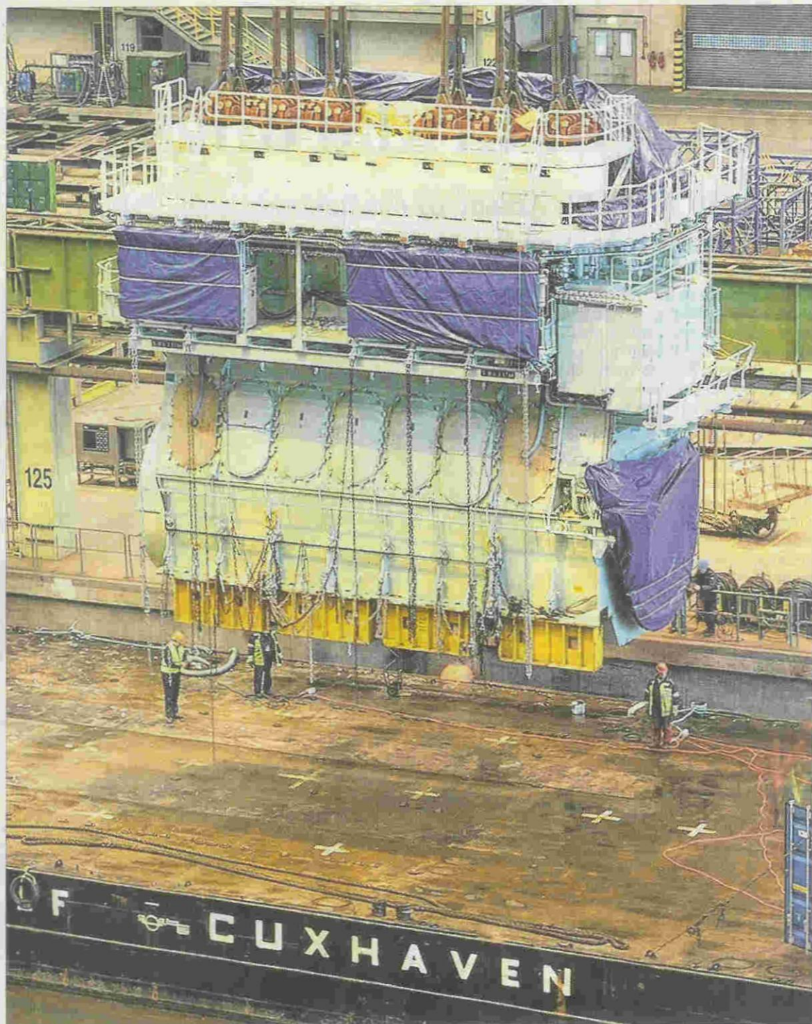
Der 550 Tonnen schwere Motor wird auf einen Ponton umgeladen.
